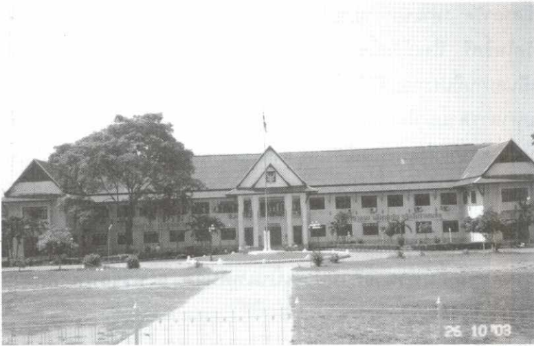
ศาลากลาง หลังที่ ๓ สร้างเสร็จ ๒๔๙๖
